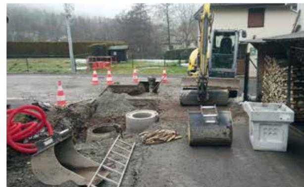
Nous profitons également de la réfection totale de la rue des Champs pour remplacer la conduite d'eau potable, les branchements sur le domaine public, ainsi que la conduite de collecte des eaux pluviales, qui était effondrée à plusieurs endroits.
