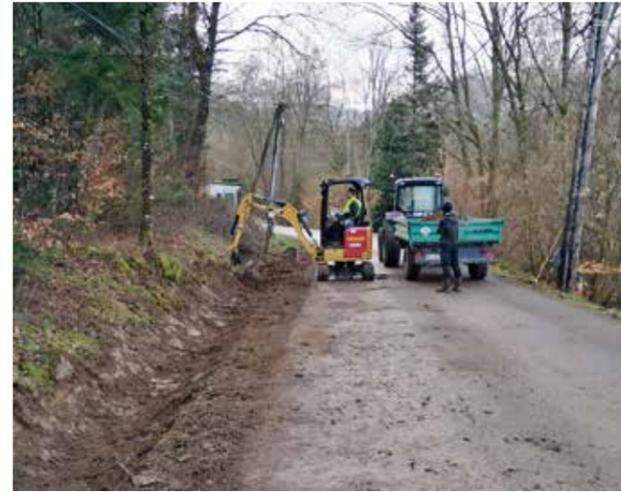
Afin d'éviter l'écoulement des eaux pluviales sur la chaussée, il a fallu s'attaquer aux fossés encombrés et saturés à l'aide d'une pelle mécanique de location. À la fin de ce mois de février, nous avons ainsi récupéré un terreau de qualité.
